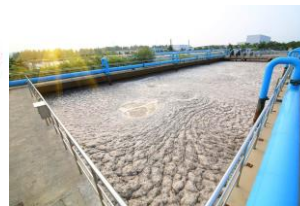
Fanghe di depurazione
